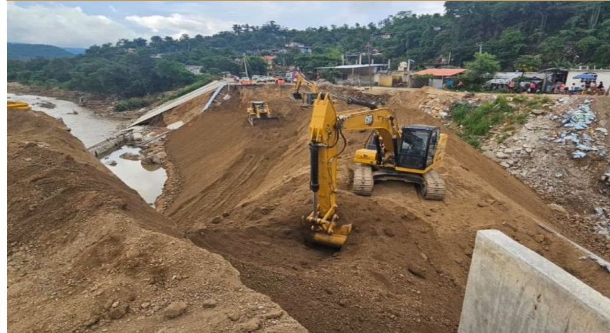
Carretera Acapulco-Pinotepa Nacional Km 106+000
