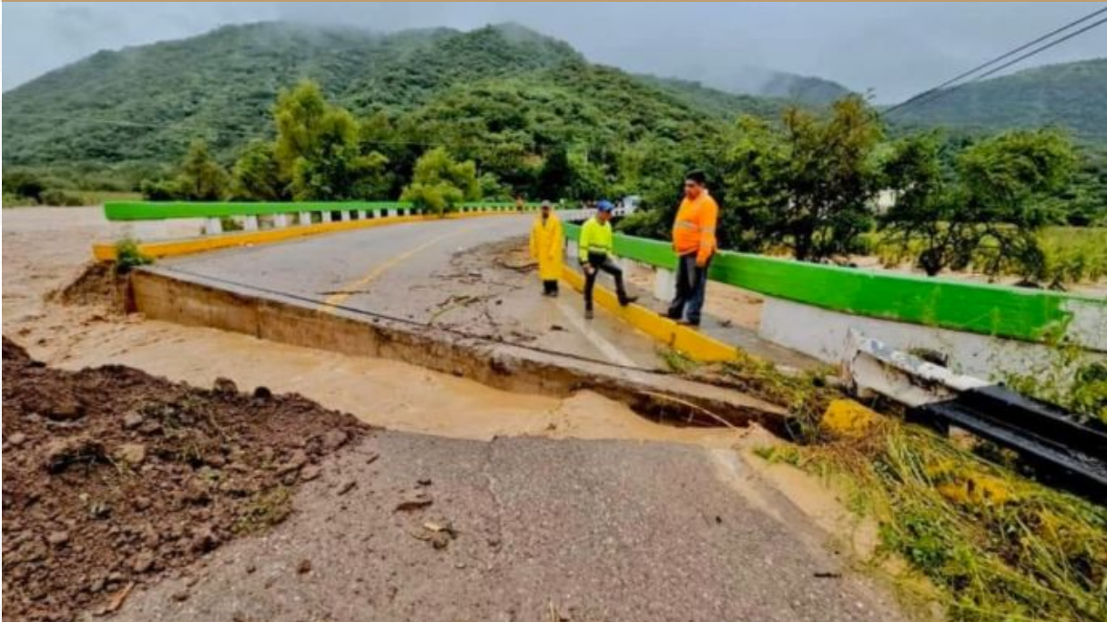
Carretera Chilpancingo-Acatlán de Osorio Km 169+000
