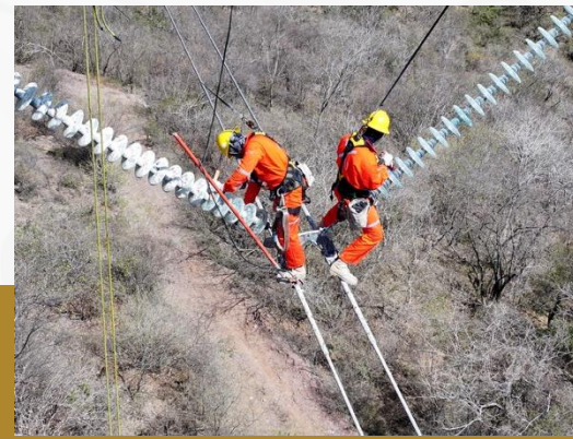
Limpieza de aislamiento en muerto
