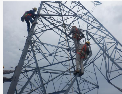
Reposición de acero en Líneas de Transmisión
