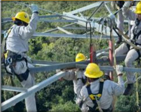
Mantenimiento mayor a Líneas de Transmisión
