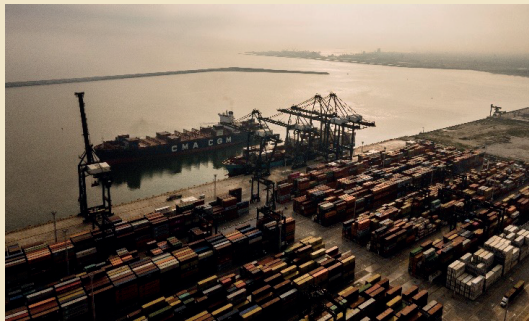
TERMINAL ESPECIALIZADA DE CONTENEDORES ICAVE (BAHÍA NORTE)
